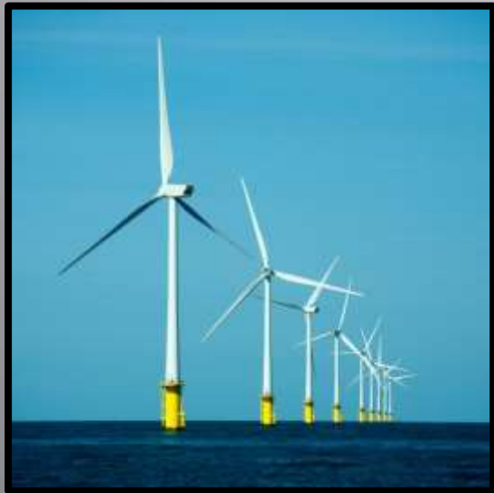
Obr. č. 13: Větrná elektrárna
