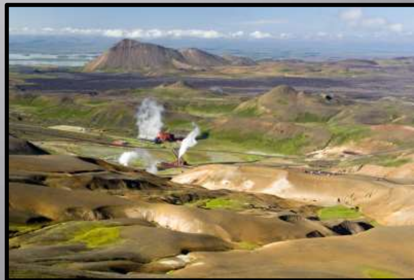
Obr. č. 8: Elektrárna
